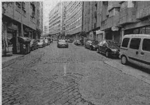
La avenida de Vilagarcía estará en obras el año próximo. XÓAN A. SOLER
